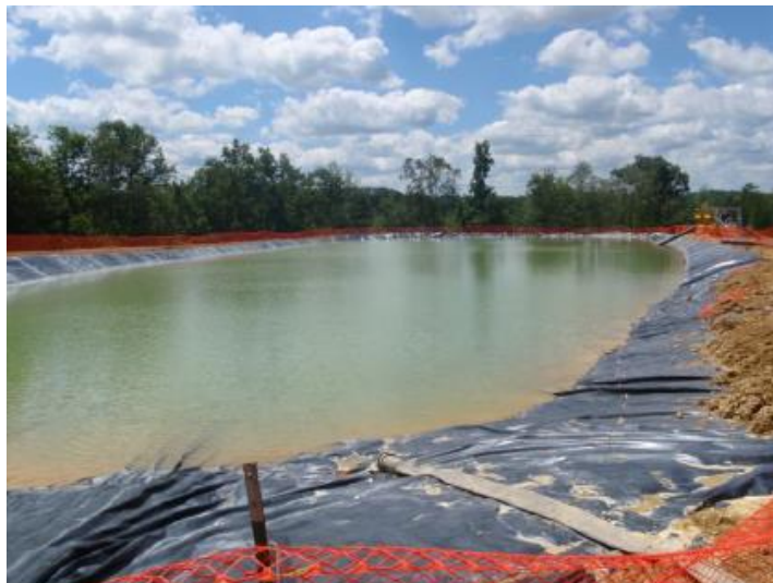
Rysunek 1. Zbiornik na wodę wykorzystywaną podczas szczelinowania hydraulicznego
